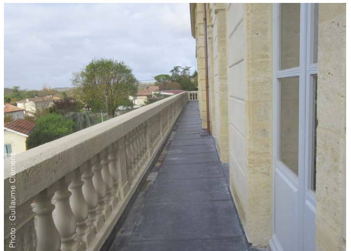
↑ Couverture en plomb du balcon.
